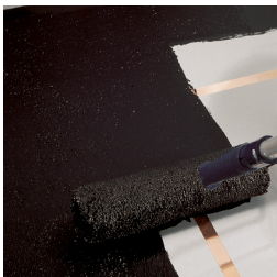
Stratul conductor constă dintr-o dispersie apoasă de rășini epoxidice cu adaos de negru de fum
